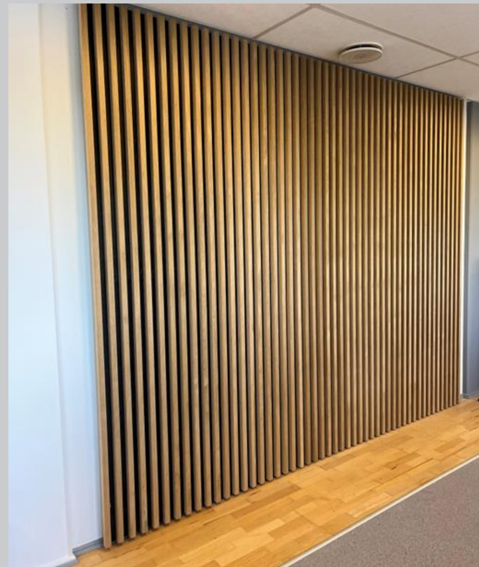
Eksempel på installation af Rockfon Timber Væg med kant D
